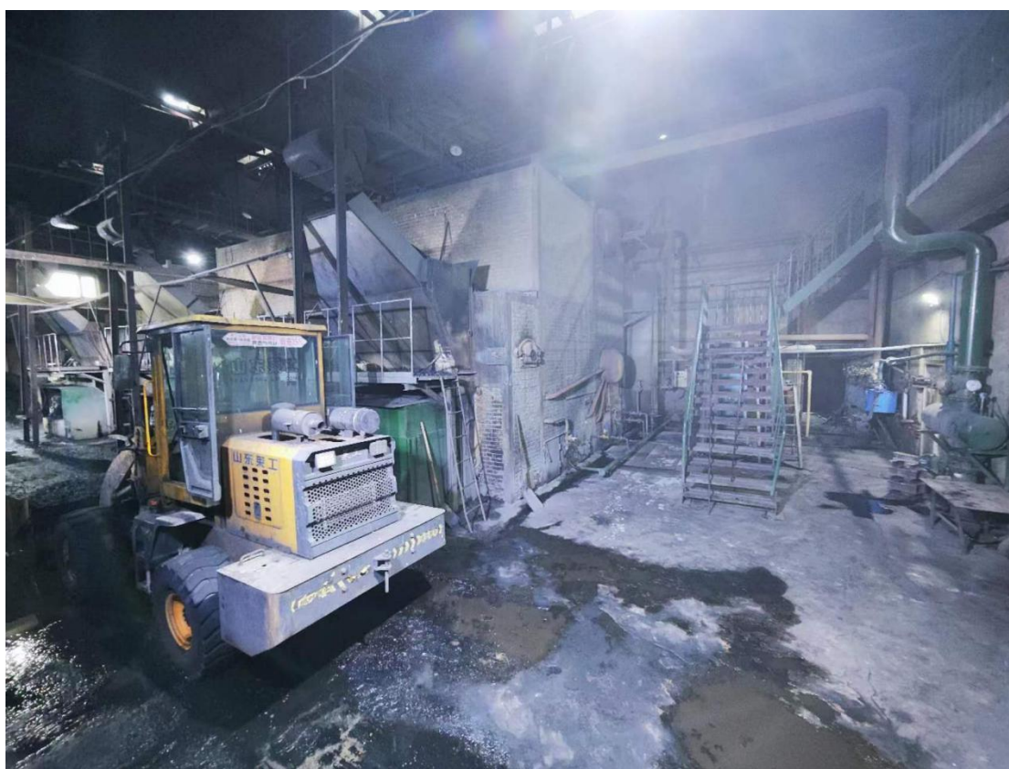
3、现场检测影像
